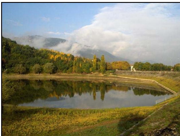
Foto 5. Lago San Raniero (AQ) (particolare della diga).
